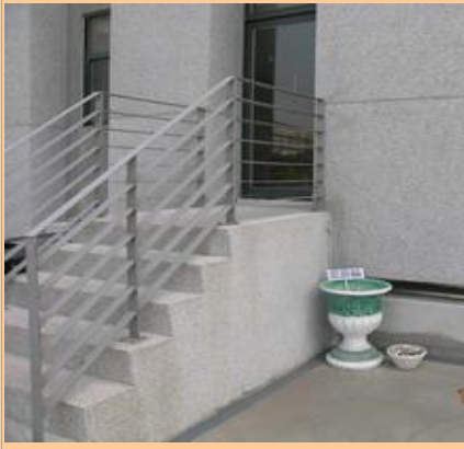
新管院大樓三樓西側屋頂陽台
